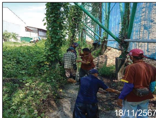
ภาพที่ 21 ขุดลอกรางระบายน้ำรอบลานกองเก็บกากตะกอนหม้อกรองและลานกองเศษอ้อย
