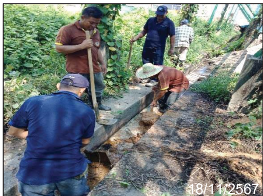
ภาพที่ 21 ขุดลอกรางระบายน้ำรอบลานกองเก็บกากตะกอนหม้อกรองและลานกองเศษอ้อย
